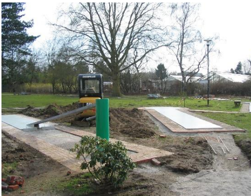
Foto: Neubau der Bahn 18
