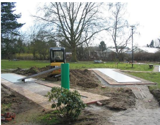
Foto: Neubau der Bahn 18
